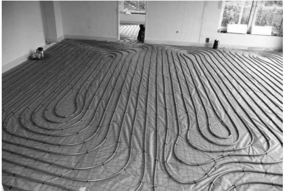
*Muckelig warm: Die Heizschlangen der Fußbodenheizung im großen Gruppenraum sind verlegt und werden nach Aufbringen des Estrichs wohlige Wärme verbreiten.*
